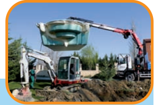
Instalación del casco
