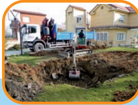
Excavación del hueco
