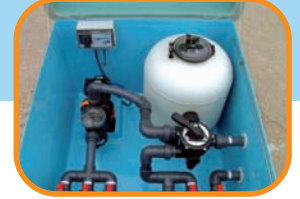
Conexión de la depuradora automática
